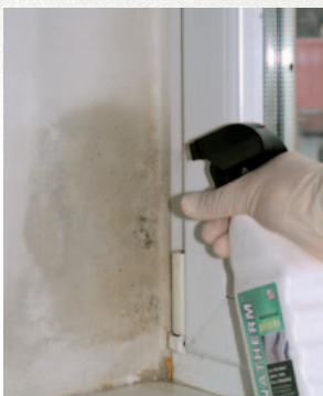
plísň odstraňte za mokra, po vyschnutí aplikujte SANATHERM ostřařovač plísní
