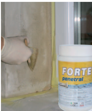
savé porchy penetrujte hmotou FORTE penetral
